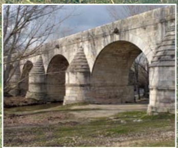
1 Puente del Retamar
